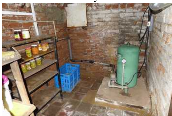
sklep s vodárnou
